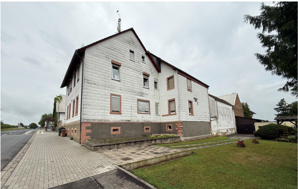
Foto 3: Blick aus Richtung der Stammheimer Straße in Richtung Südwesten auf das Wohngebäude (Quelle: Büro Zillinger, Juli 2025)
