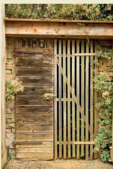
Der rechte Türflügel wird im Sommer eingesetzt und sorgt für den gewünschten Luftaustausch.
